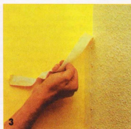
3 Края стен обклеивают защитной лентой.
