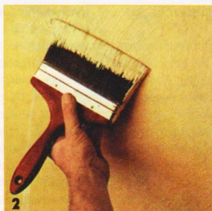
2 Штукатурку наносят на стену с помощью кисти или лопатки.
